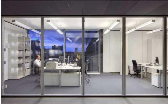
luminaires suspendus Ecoos de longueur double fut installé sur les axes du bâtiment. Ils peuvent en option être combinés avec une unité de commande moderne, afin d'assurer l'ajout optimal d'éclairage artificiel en fonction des besoins. Une des conditions
