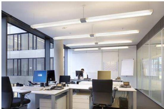
composante directe. Celle-ci est équilibrée par l'éclairage indirect du plafond et de la pièce assuré par la vasque diffusante. La technologie MPO+ élargit la flexibilité d'Ecoos en réduisant l'éblouissement de la lampe, de sorte que le luminaire peut être positionné directement au-dessus du poste de travail.
