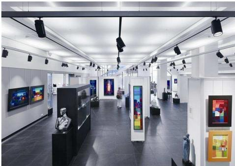
**Image 2 :** Au total, 230 projecteurs montés sur des rails Supersystem assurent la mise en scène des œuvres d'art.
