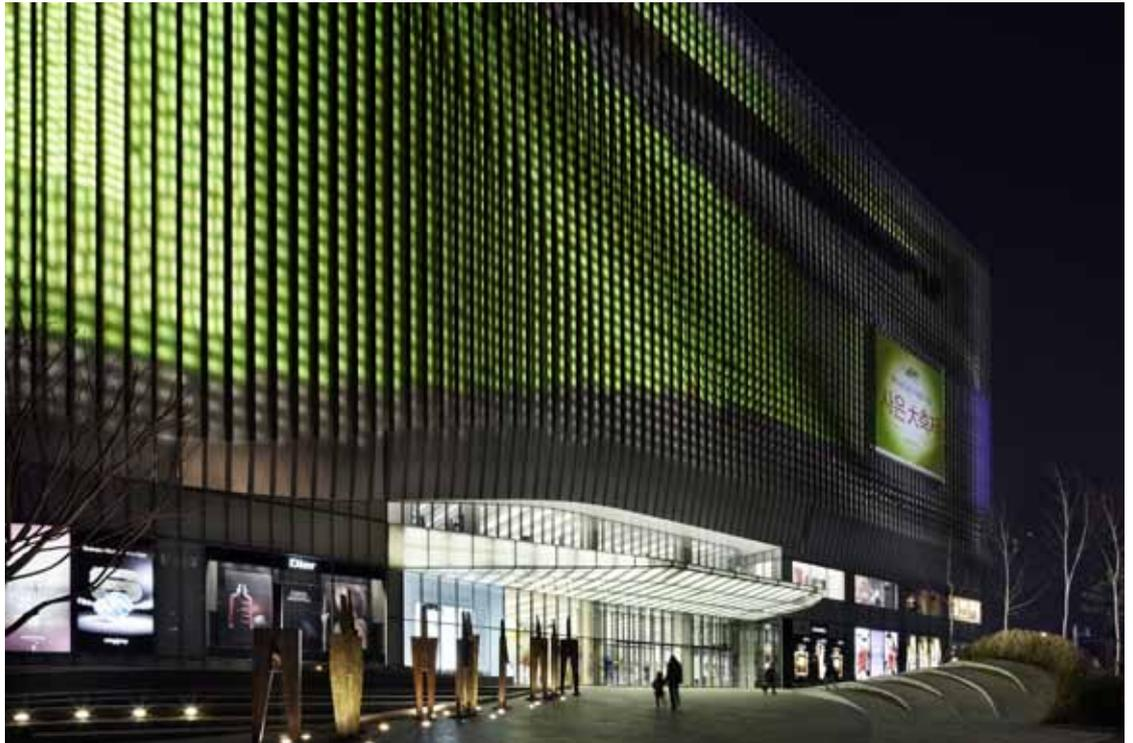
B2 | Plus de 22 000 projecteurs à LED sont pilotés individuellement à l'aide d'une commande DMX. Adaptés les uns aux autres, ils offrent un éclairage de façade extraordinaire. Zumtobel a réalisé la solution lumière spécifique au projet d'après le concept de ag Licht.
