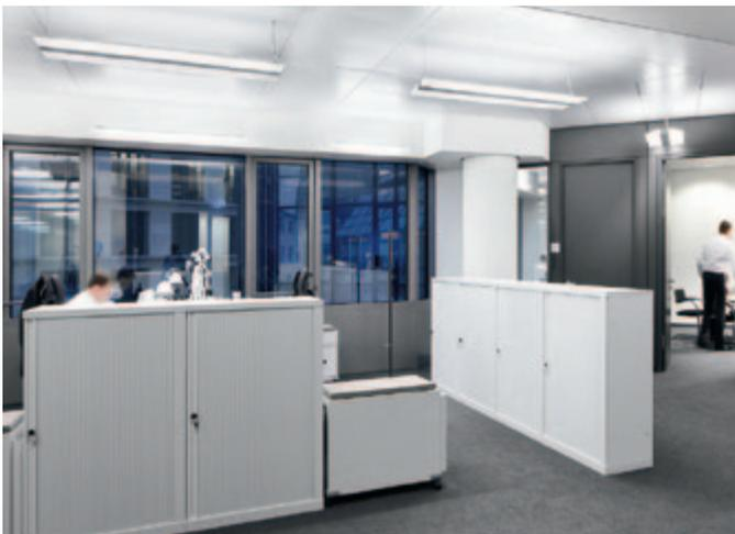
Als Pendelvariante erhellt die Schwertleuchte unter anderem die Arbeitsplätze im Sockelgeschoss (links). Das Trägerprofil der zweiseitig bestückten Leuchten wird von schwertförmigen Lichtprismen umrahmt (unten).
