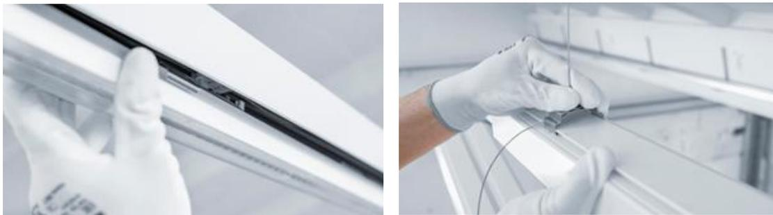
**Bild 3a + b:** Bis zu 50 Meter des IP65-Lichtbands können am Stück installiert werden. Schienen, Lichtbalken und Lichtbausteine werden dabei in metrischen Maßen gefertigt.
