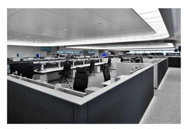
**Bild 2:** Die Sonderlichtlösung von Zumtobel arbeitet mit Lichtdeckenfelder aus hinerleuchteten mikroprismatischen Platten, die einen Oberlichteffekt erzeugen und auch an Arbeitsplätzen in der Raumtiefe für einen Tageslichteindruck sorgen.
