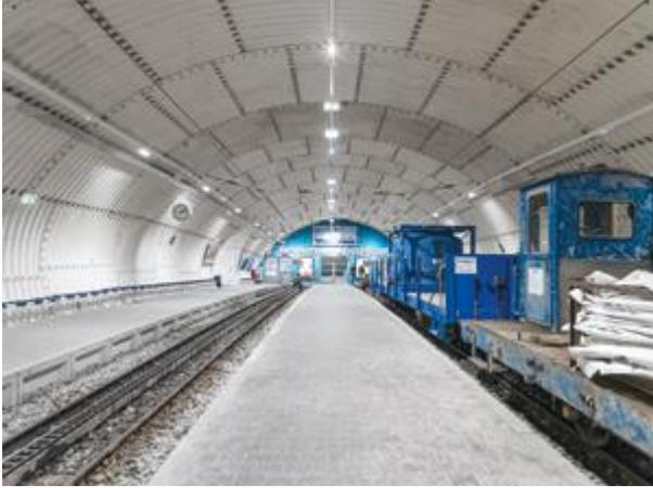
**Bild 3:** Im Bahnhof kommt CRAFT mit wide beam-Optik zum Einsatz, um das Tonnengewölbe bei optimaler Entblendung effizient und gleichmäßig zu beleuchten.
