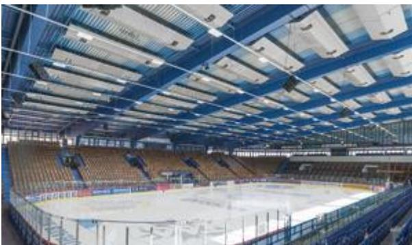
**Bild 5:** CRAFT bietet eine hohe Brillanz und Farbwiedergabe sowie eine optimale Entblendung – das ist besonders wichtig, um ein Reflektieren auf der Eisfläche zu verhindern.
