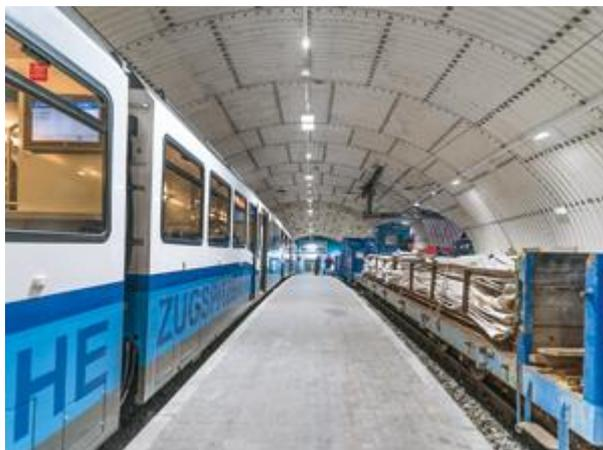
**Bild 2:** Für die neue Beleuchtung des Gletscher-Bahnhofs Zugspitzplatt, war CRAFT die erste Wahl. Die Leuchte gilt mit ihrer hohen Schutzart IP 65 als äußerst widerstandsfähig und trotzt auch den widrigsten Wetterbedingungen.
