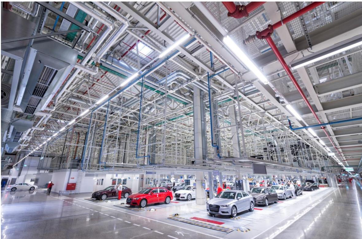
**Bild 2:** In den Montagehallen wurden über 140 Kilometer des Lichtbandsystems TECTON verbaut.
