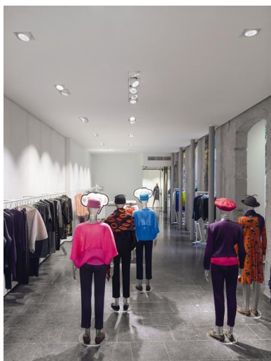
Bild 3: Auf die Puppen sind jeweils ein Akzentstrahler mit Spot- und einer mit Flood-Charakteristik des Beleuchtungssystems INTRO gerichtet, das bündig in der Decke eingepasst ist.
