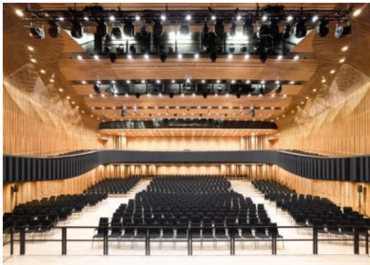
Bild 3: Eine individuelle Steuerung von Lichtstimmungen wie hier im Großen Saal erzeugt je nach Anlass oder Inszenierung eine eigene Atmosphäre (Kaltweiß, neutralweiß und warmweiß).
